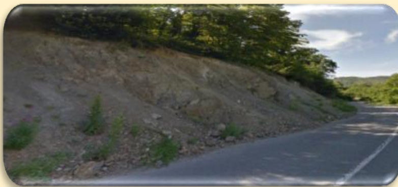
Slika 1: Sa dijela puta prije rekonstrukcije; izvor: Glavni projekat
